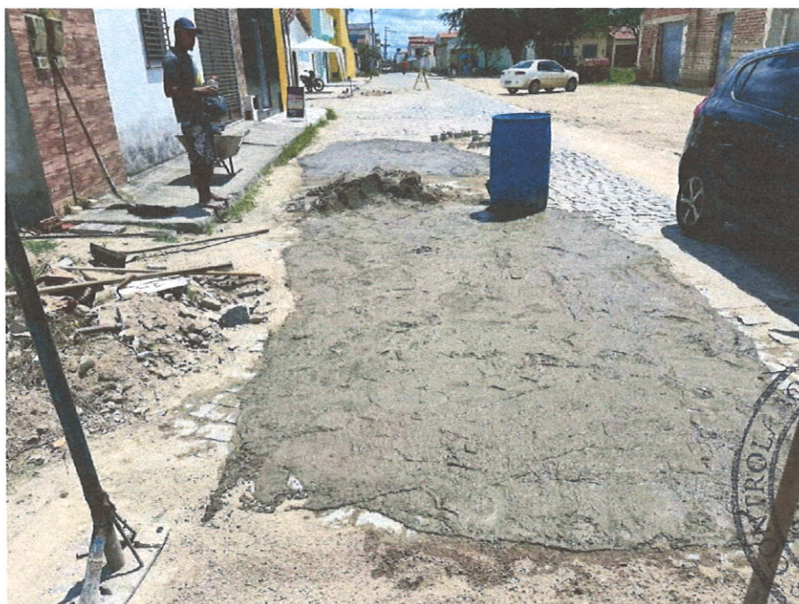
Foto 08- Reassentamento de paralelepípedo, rejuntamento com argamassa.
