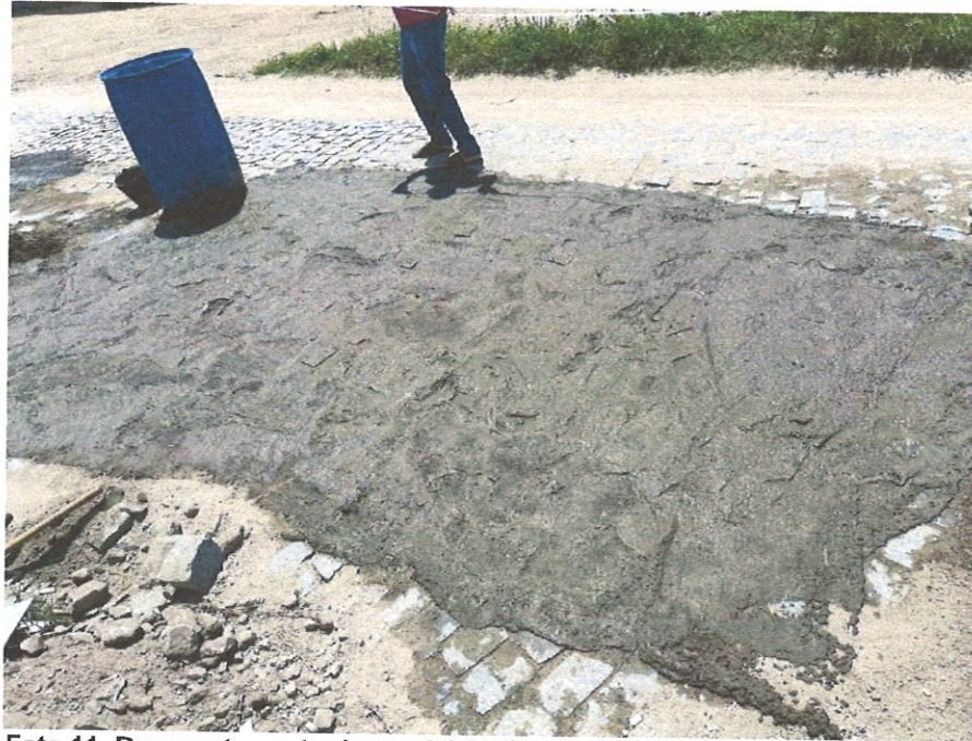
Foto 11- Reassentamento de paralelepípedo, rejuntamento com argamassa.
