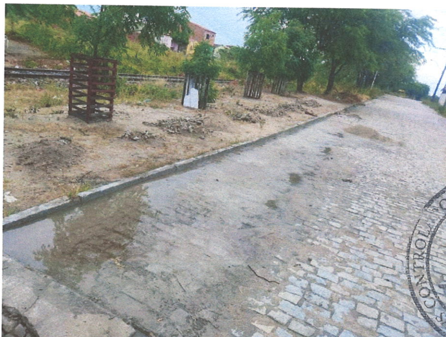
Foto 12- Reassentamento de paralelepípedo, rejuntamento com argamassa.
