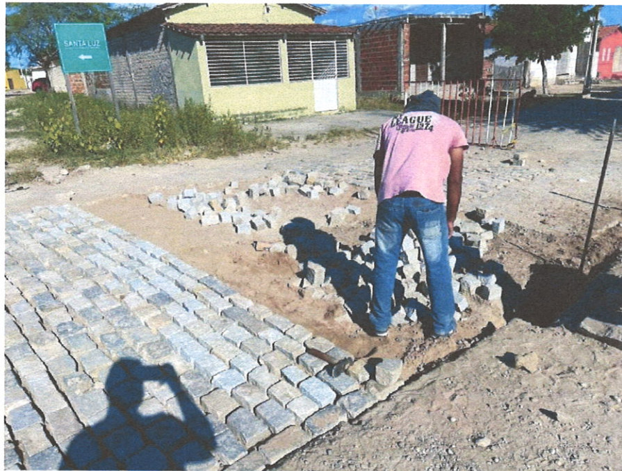
Foto 01- Reassentamento de paralelepípedo
