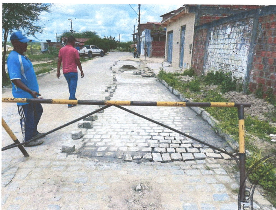
Foto 04- Reassentamento de paralelepípedo
