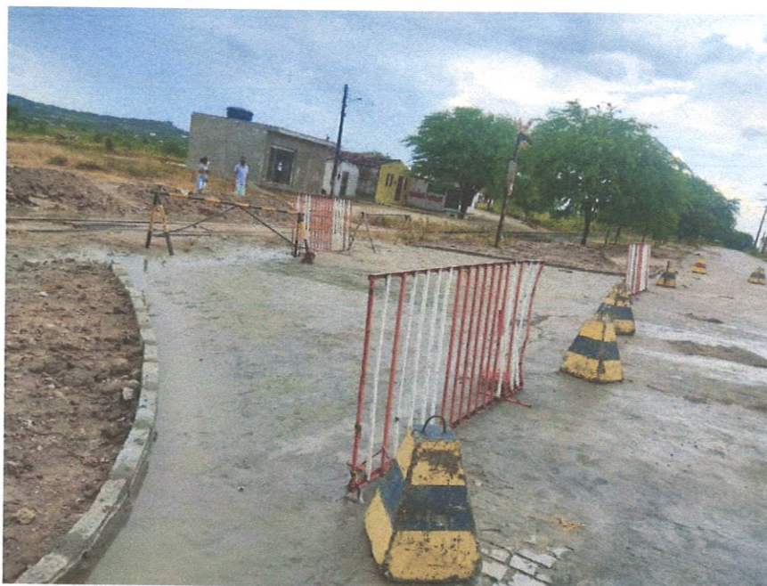
Foto 15- Escavação e retirada de solo borrachudo, incluindo remoção.
