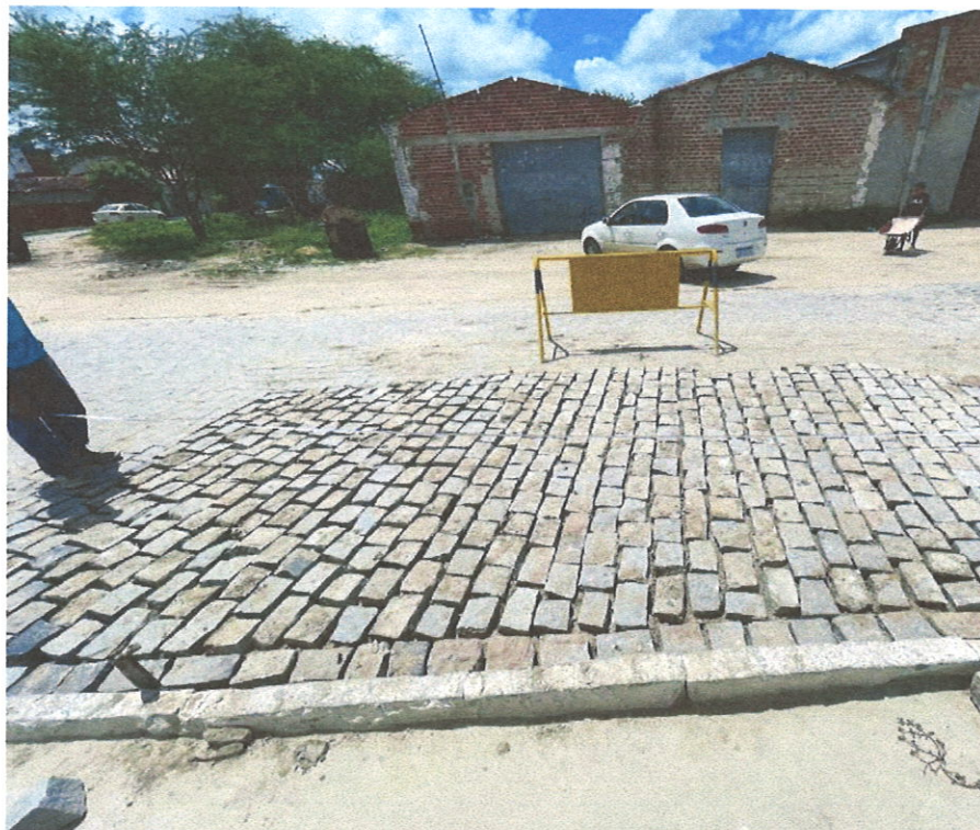
Foto 05- Reassentamento de paralelepípedo
