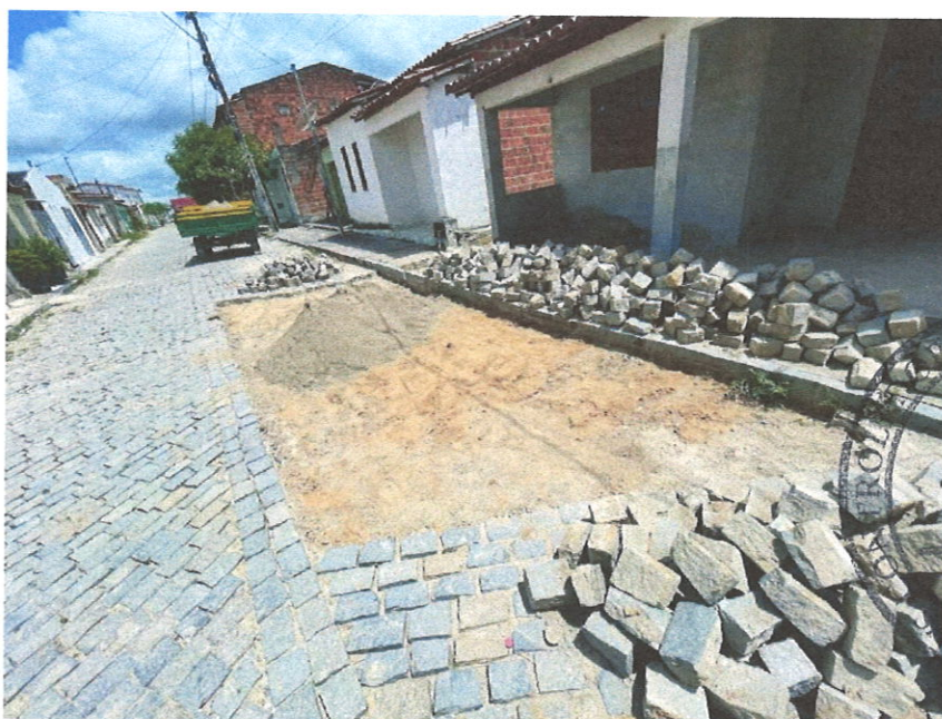
Foto 16- Reassentamento de paralelepípedo, rejuntamento com argamassa/ Aterro com pó de brita – areia grossa
