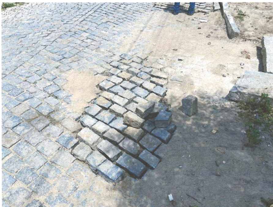
Foto 07- Reassentamento de paralelepípedo.
