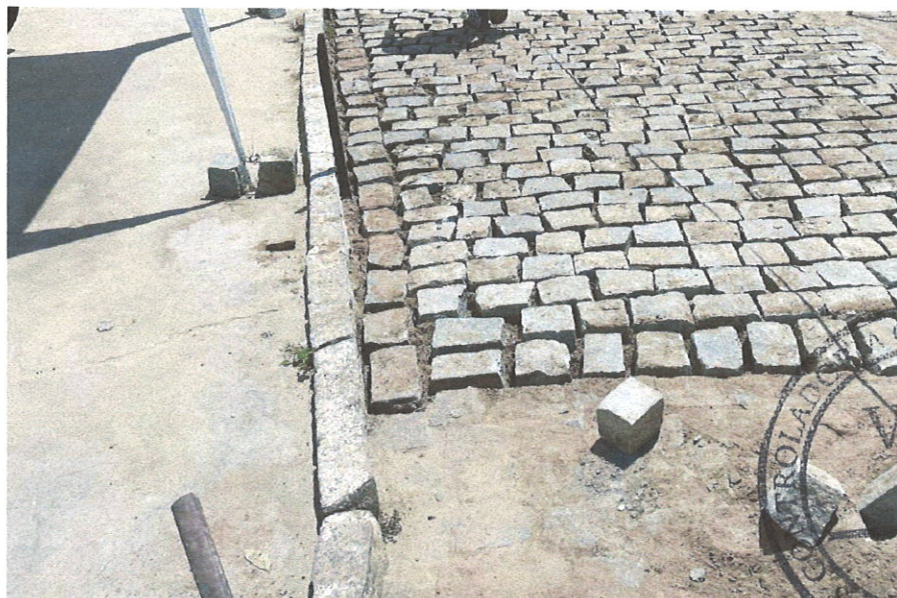
Foto 06- Reassentamento de paralelepípedo
