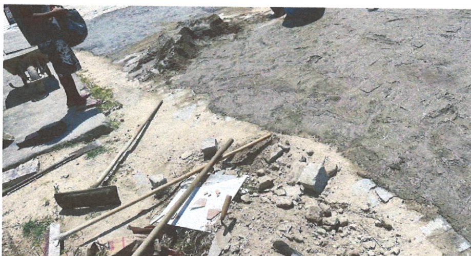
Foto 10- Reassentamento de paralelepípedo, rejuntamento com argamassa.
