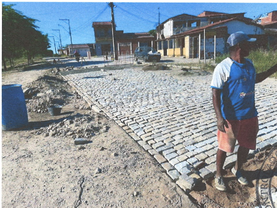
Foto 02- Reassentamento de paralelepípedo
