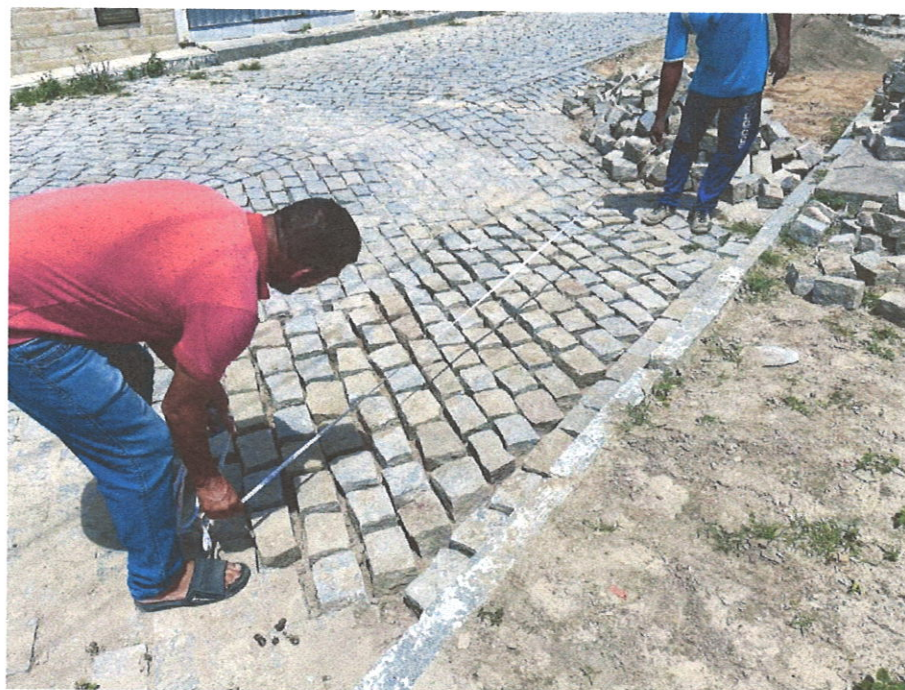
Foto 03- Reassentamento de paralelepípedo
