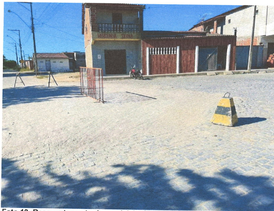
Foto 13- Reassentamento de paralelepípedo, rejuntamento com argamassa.
