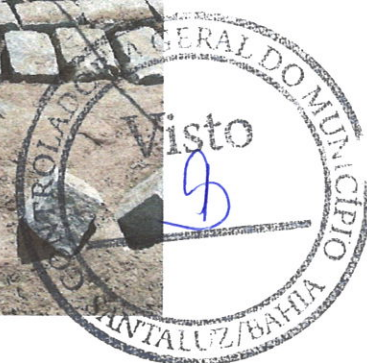
Foto 06- Reassentamento de paralelepípedo
