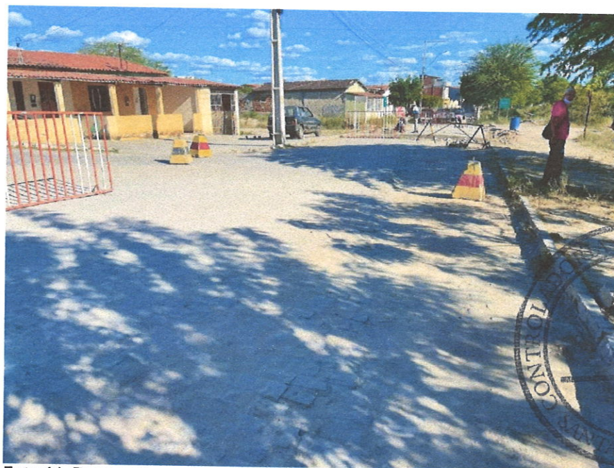
Foto 14- Reassentamento de paralelepípedo, rejuntamento com argamassa.
