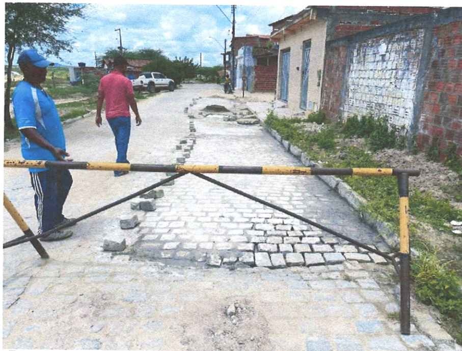
Foto 09- Reassentamento de paralelepípedo, rejuntamento com argamassa.
